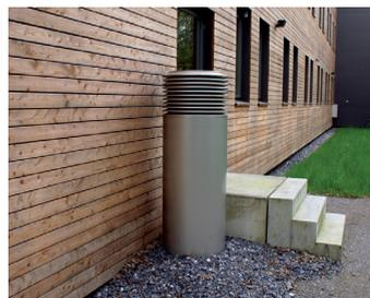
Presa d'aria per sistema di ventilazione meccanica.
