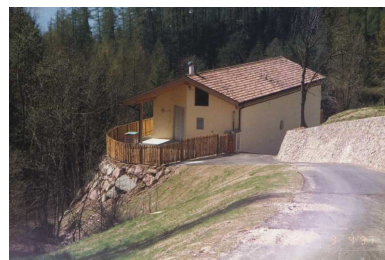
Immagine dell'impianto di depurazione
