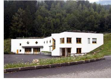
Immagine dell'impianto di depurazione
