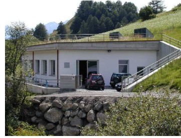
Immagine dell'edificio dell'impianto di depurazione
