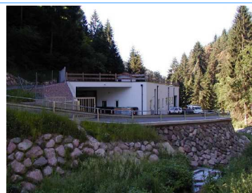
Immagine dell'impianto di depurazione
