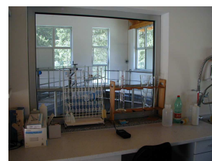
Immagine dell'impianto di depurazione
