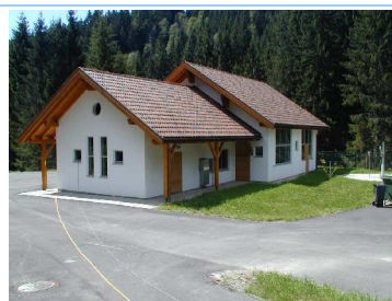
Immagine dell'impianto di depurazione
