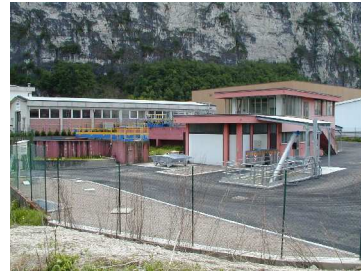
Immagine dell'impianto di depurazione
