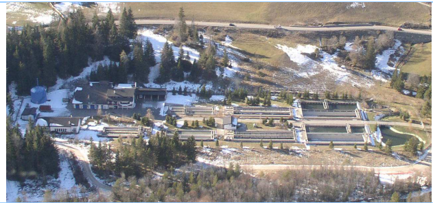
Immagine dell'impianto di depurazione
