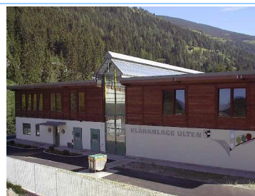
Immagine dell'impianto di depurazione
