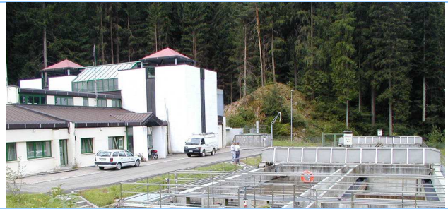
Immagine dell'impianto di depurazione
