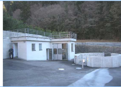
Immagine dell'impianto di depurazione
