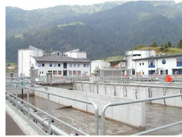
Immagine dell'impianto di depurazione
