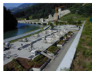
Immagine dell'impianto di depurazione
