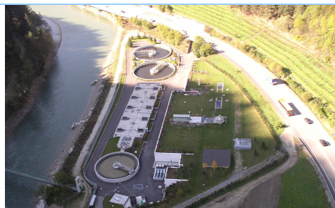
Immagine dell'impianto di depurazione
