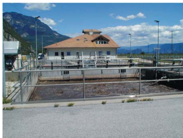
Kläranlage Margreid Impianto di depurazione di Magrè
