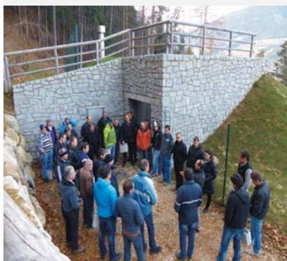
Teilnehmer an der Praxisfortbildung für Wasserwarte vor dem Trinkwasserspeicher in Milland bei Brixen
