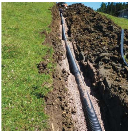
Bau Hauptkanalisation Seiser Alm - Seis Costruzione collettore principale Alpe di Siusi - Siusi
